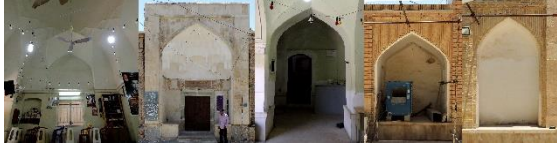
تصویر ۸: نوع قوس‌ها، به ترتیب از سمت راست: سه‌بخشی تند، سه‌بخشی کند، پنج او هفت تند، پنج او هفت کند، شبدری پاتوپا (مأخذ: نگارنده)
