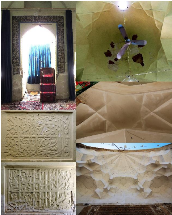
تصویر ۱۰. تزئینات: سمت راست بالا: کاربندی سازه‌ای گنبدخانه، وسط: کاربندی ایوان روبروی گنبدخانه، پایین: مقرنس سردر، سمت
