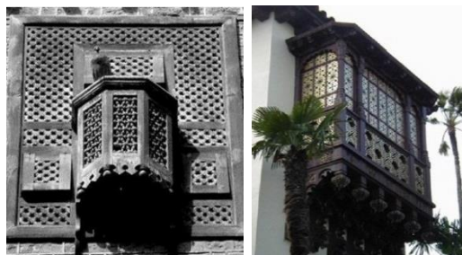
تصویر ۱- پالکانه در کالیفرنیا، (ماخذ: گنجی و دیگران، ۱۳۹۳: ۹). تصویر ۲- پالکانه در قاهره، (ماخذ: گنجی و دیگران، ۱۳۹۳: ۹).
