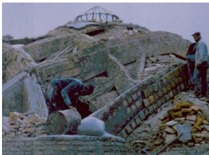
تصویر ۸: اجرای تاق دزد به شکل متقاطع با تاق های اصلی
