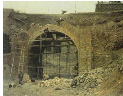
تصویر ۹: اجرای تاق رومی بر روی قالب دائمی از تاق پر، (پل شاه عباسی کرج)
