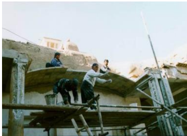
تصویر ۱۶: نحوه اجرای تاق لاپوش
