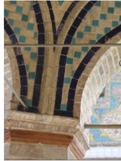
تصویر ۲: اتصال جرز با تاق به روش پیش آمده پاکار هشتی امامزاده حسین قزوین
